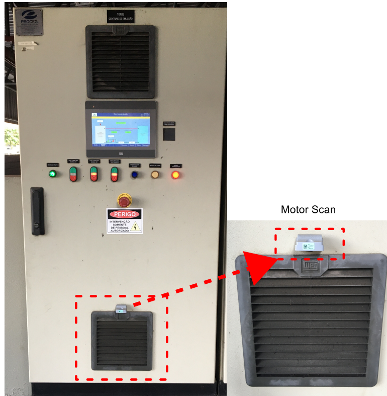
Figura 8.15: Ejemplo de la posición correcta del sensor de temperatura ambiente WEG Motor Scan en el caso de un panel que contiene un inversor
